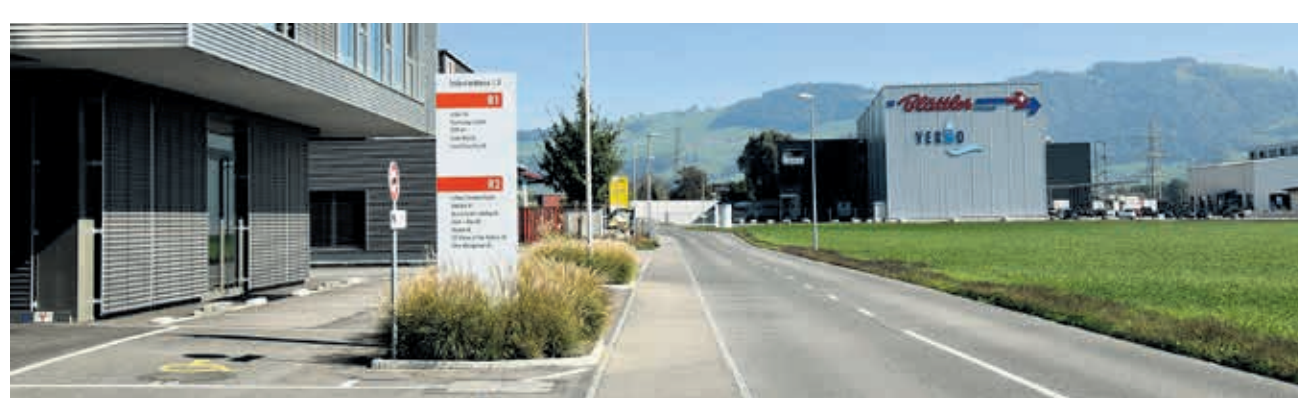
Das neue Kühllogistik-Zentrum der Firma Blättler ist Sinnbild für das Wachstum im Industriegebiet von Inwil.
