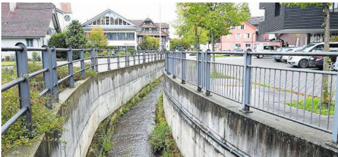
Der Wissenbach fliesst im Zentrum von Merenschwand in einem Kanal.
